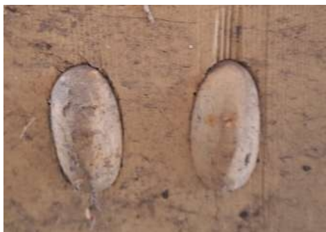
Innenseite Loselement (Rückseite der Gewindebolzen H=ca.5 cm)
